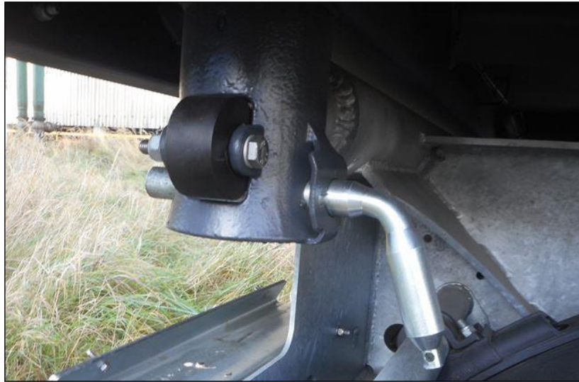
Rys. 19 - Zabezpieczony sworzeń wywrotu.
